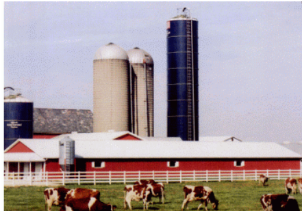
Figura 5 - Exemplos de silos aéreos.
